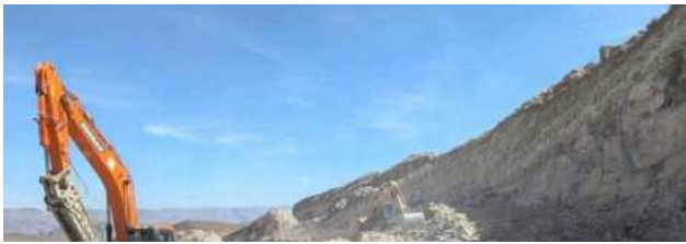
Ab und zu sind die sehr guten Straßen noch von Baustellen unterbrochen.
